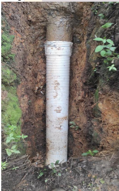
Arreglo de tubería sanitaria en Sector Miraflores
