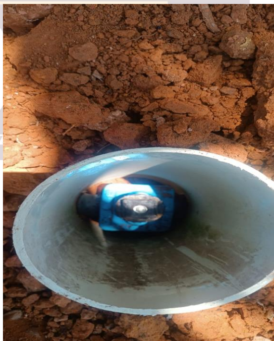
Sustitucion de valvula de control en la calle Colon
