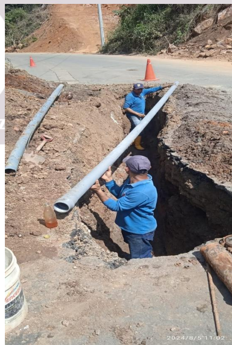
Reparación de la tubería de distribución en la Colina
