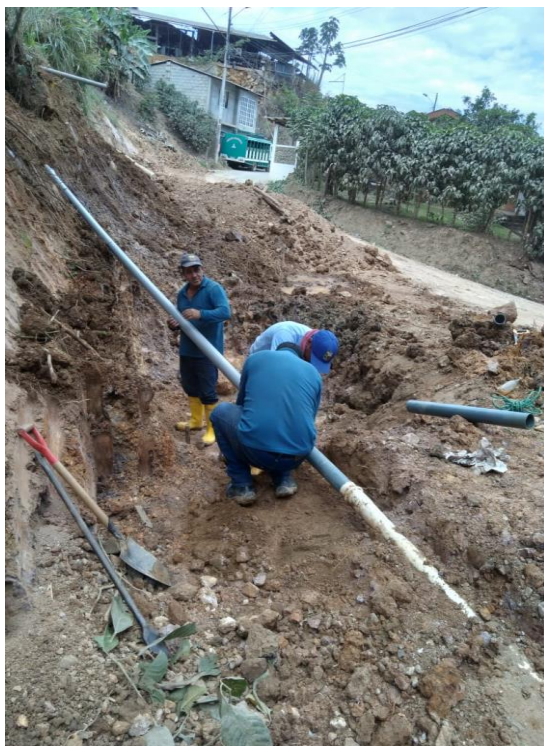
Sustitucion de valvula de control en la calle Colon
