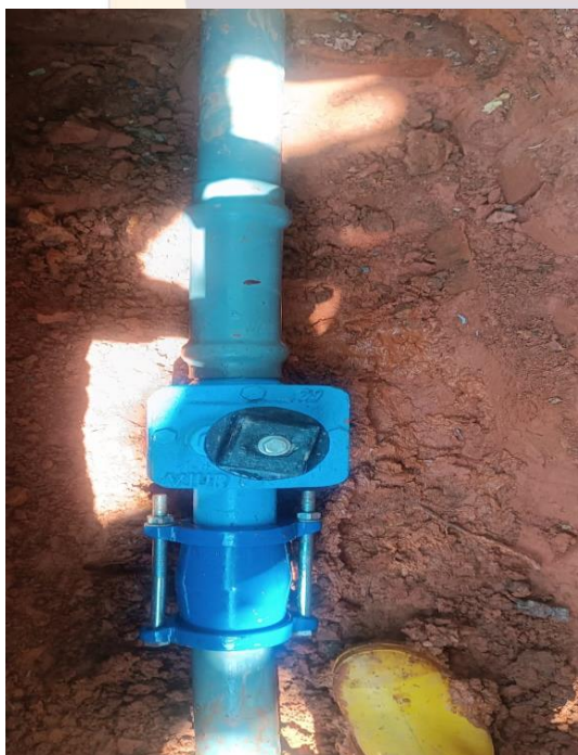
Sustitucion de valvula de control en la calle Colon
