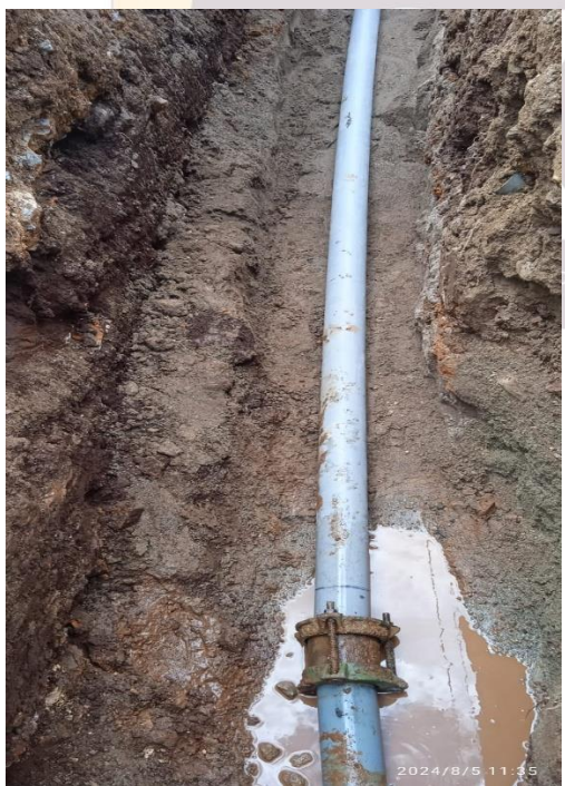
Reparación de la tubería de distribución en la Colina
